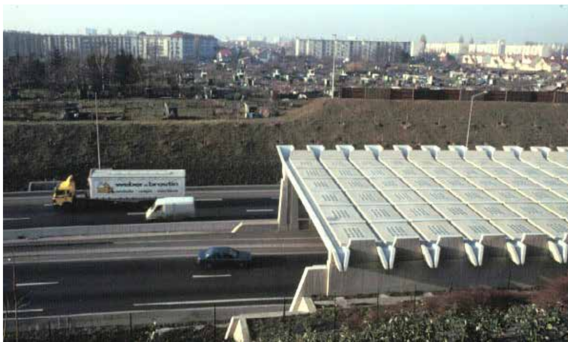
Couverture sur A86 à Thiais
